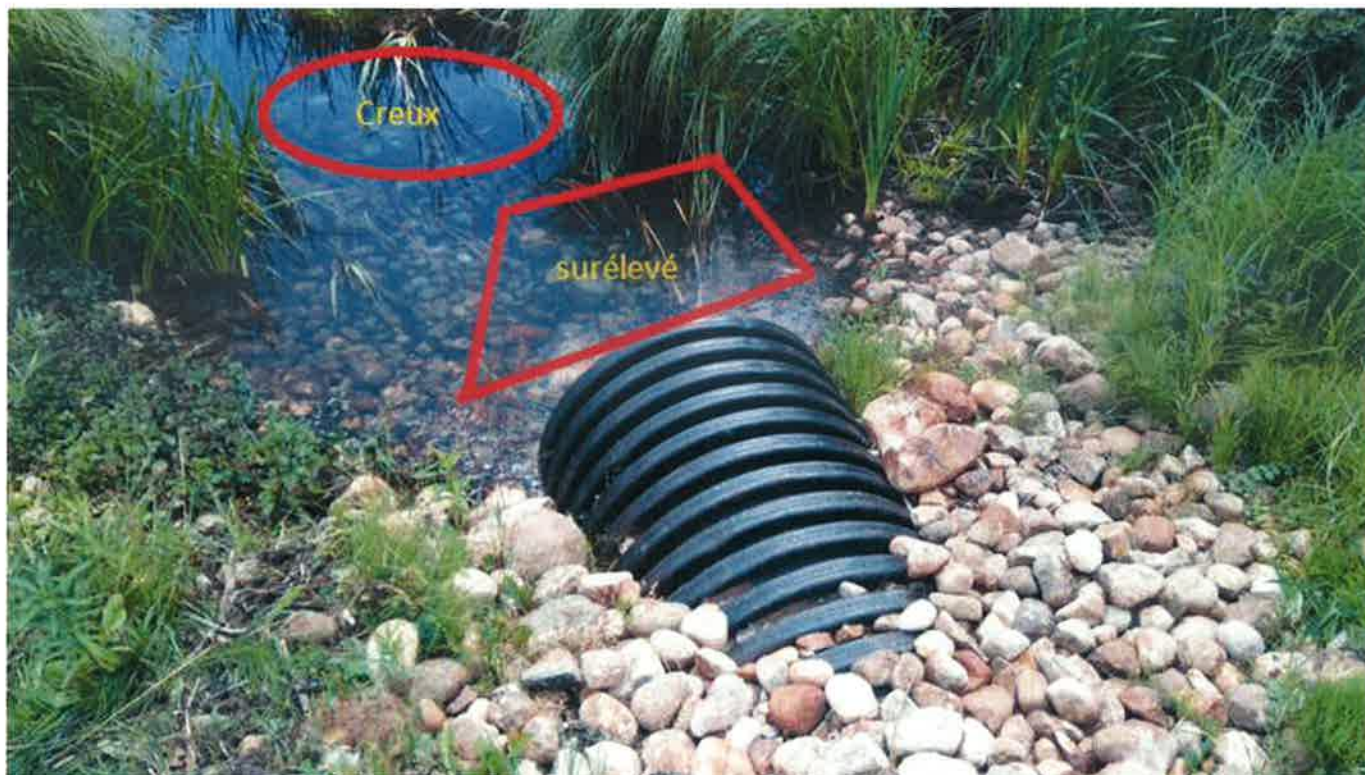
Ponceau en amont du chemin (aucun enfouissement du ponceau)
